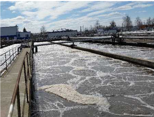
图—12 老朽化的活性污泥槽（俄罗斯）
